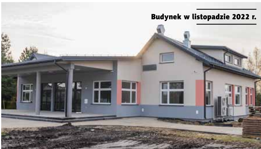
Budynek na początku kwietnia 2023 r.
