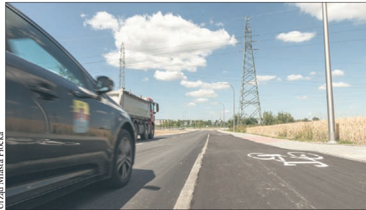
Prace na ulicy Zbożowej trwały cztery miesiące
