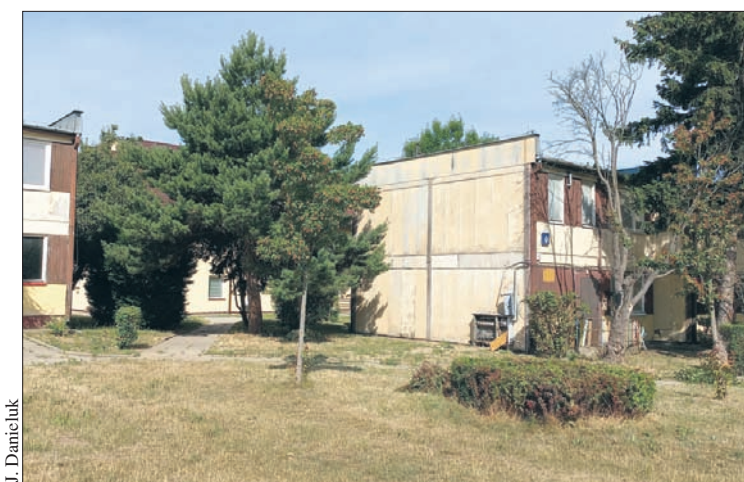
Wkrótce urząd miasta planuje ogłoszenie przetargu na wyburzenie starego budynku przy ulicy Miodowej 33 i budowę nowego obiektu
