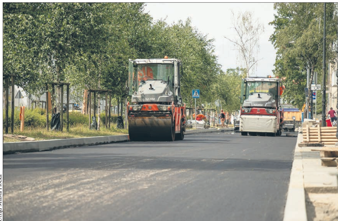
Układanie asfaltu na jezdni pl. Dąbrowskiego
