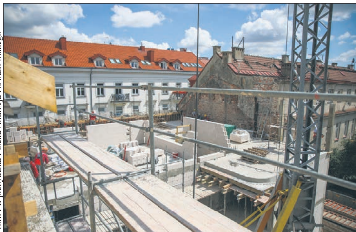
Prace przy ul. Grodzkiej 8
