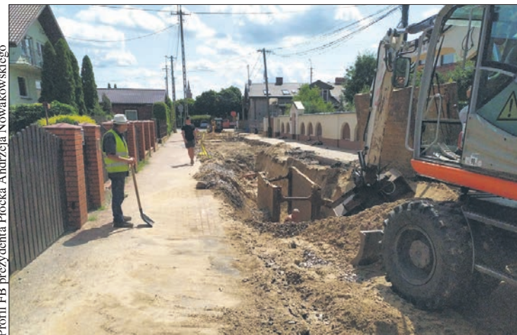
Trwa przebudowa kolejnego fragmentu ulicy Zielonej
