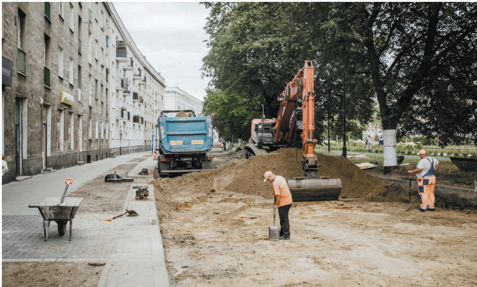
Na ul. Podczaszyńskiego rozpoczęły się prace związane z wymianą nawierzchni jezdni. Fot. S. Supino.
