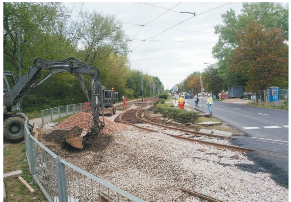
Na ul. Nocznickiego tramwajarze wyremontowali przejazd, a teraz będą prowadzić prace na torach wzdłuż ulicy i na wlocie ul. Rokokowej. Fot. arch. red.
