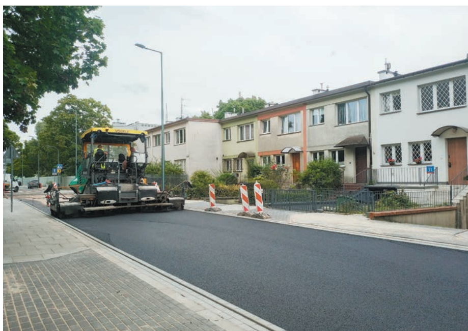
Remont ul. Staffa na odcinku między ulicami Makuszyńskiego a Perzyńskiego. Fot. arch. red.
