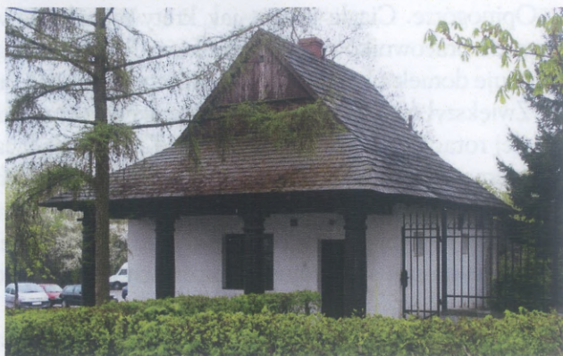
Fot. 37. Opinogóra, domek z kolumnami obecnie.
