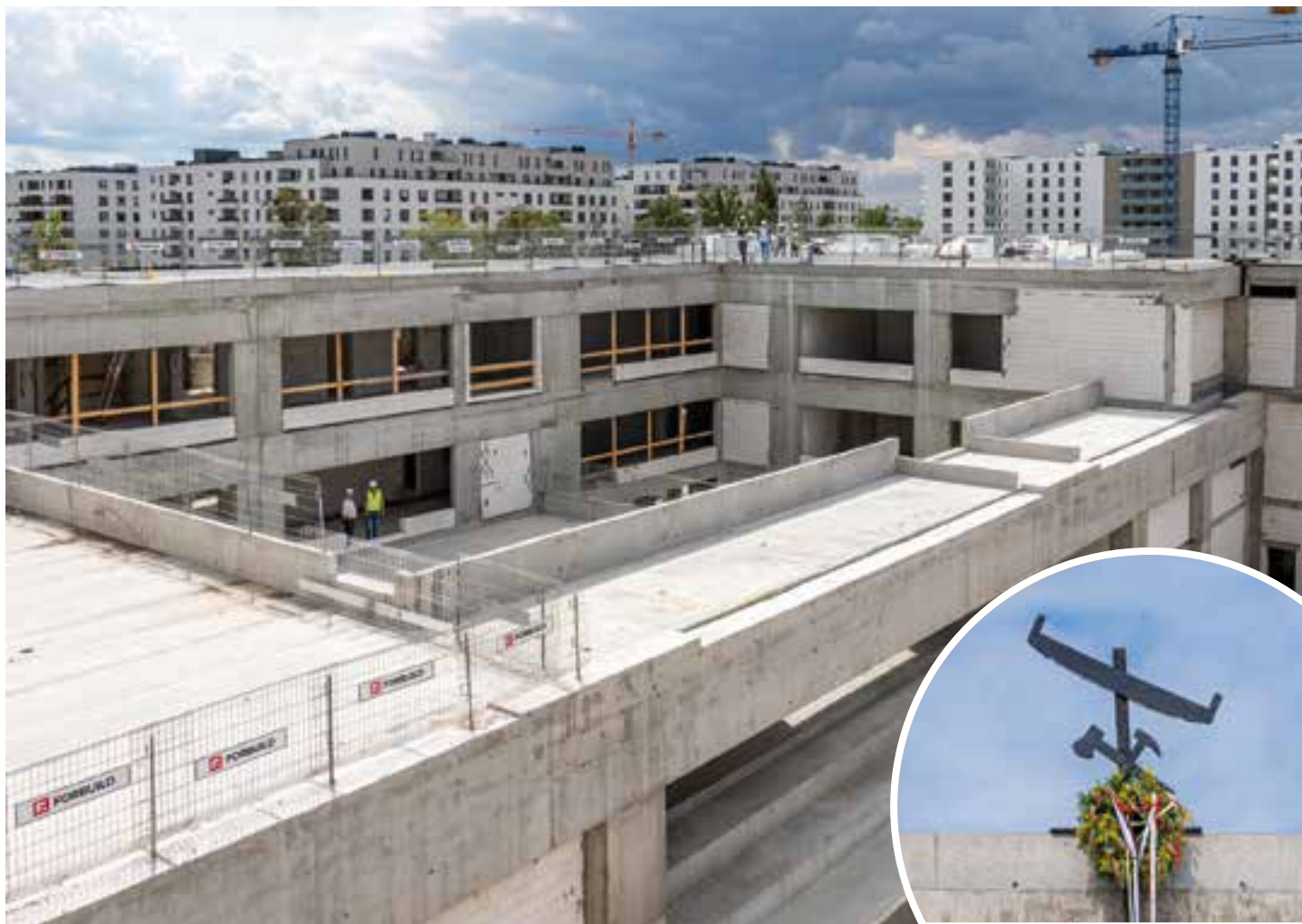
Budowa szkoły podstawowej przy ul. Silnikowej, róg ul. T. Hennela, fot. W. Sokołowski.
