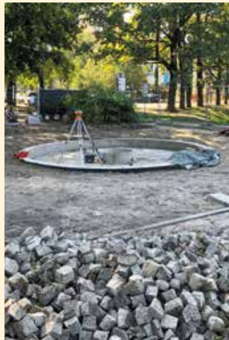
Budowa fontanny posadzkowej w Parku Achera, fot. W. Sokółowski.
