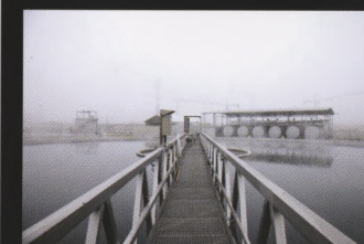
Oczyszczalnia Ścieków „Czajka”, osadnik wtórny
