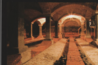
Wnętrze filtra powolnego. Pośrodku kanał zbiorczy dla przefiltrowanej wody
