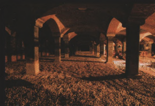
Wnętrze filtra powolnego podczas wymiany złoża filtrującego
