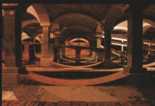
Wnętrze opróżnionego filtra powolnego
