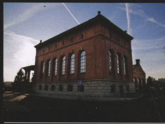
Lindleyowska hala pomp na Stacji Filtrów
