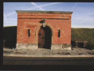
Przedsiónek filtra powolnego na Stacji Filtrów
