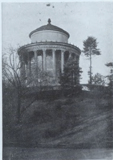
Rys. 1. Zbiorniki wodociągów Markoni (1855÷1889).
