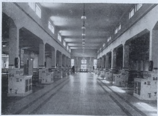
Rys. 8. Hala filtrów pośpiesznych.
