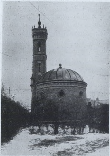
Rys 3. Wieża ciśnień i zbiornik wodociągów praskich (1869÷1896).
