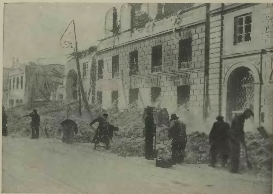
Aufräumungsarbeiten in Warschau Oktober 1939
