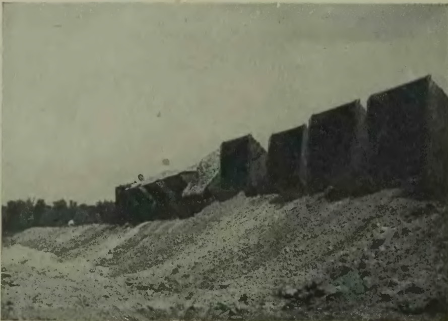
Bau eines Dammes gegen Überschwemmungen
