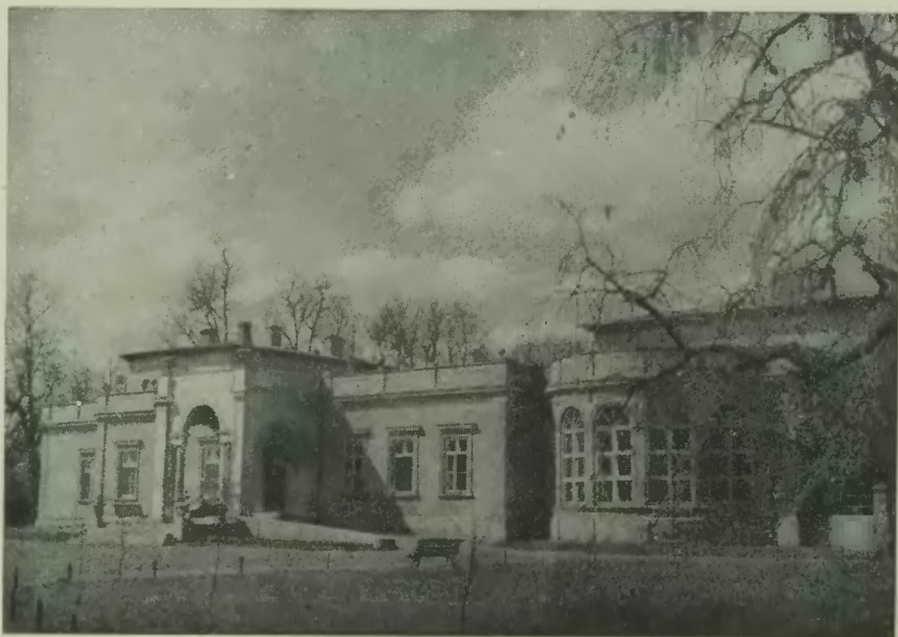
Dienstgebäude des Kreishauptmanns in Sokolow
