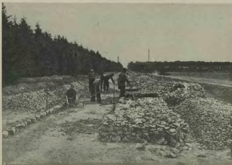
Strassenbau im Distrikt Warschau
