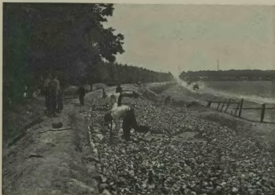
Neubau einer Strasse bei Warschau
