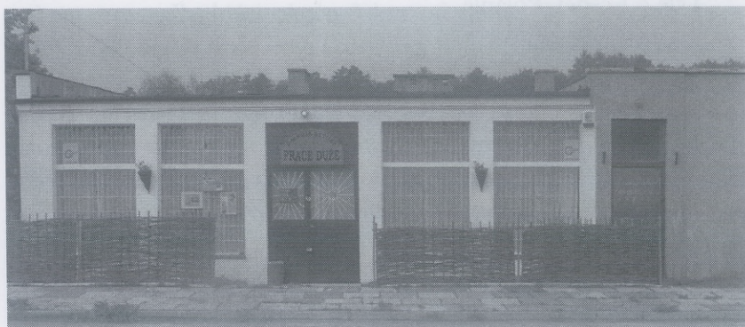
Galeria Foggów w Pracach Dużych. Arch. GOK Tarczyn.
