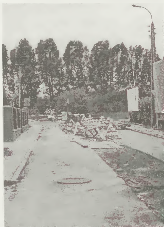
Budowa kanalizacji na ul. Wylot
