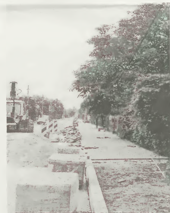
W trakcie prac nad budową chodnika na ul. Latarnika
