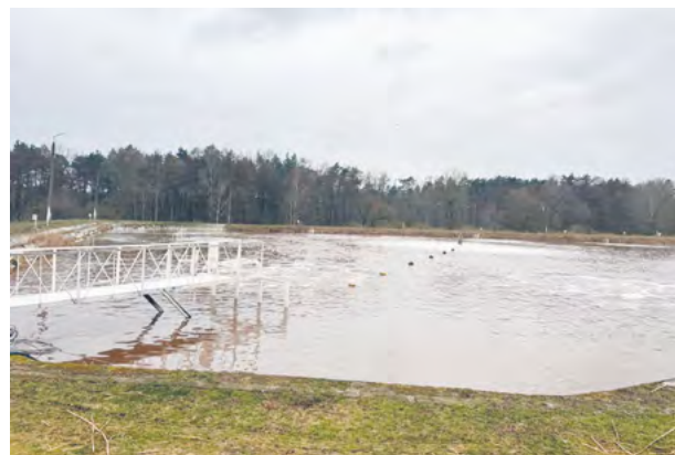
Oczyszczalnia ścieków w Drozdach
