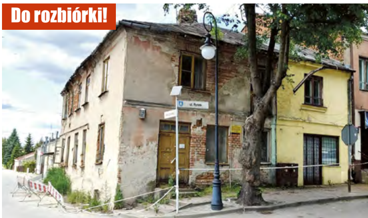
Kamienica do rozbiórki - ul. Rynek
