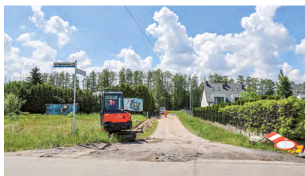
Budowa ul. Olchowej
