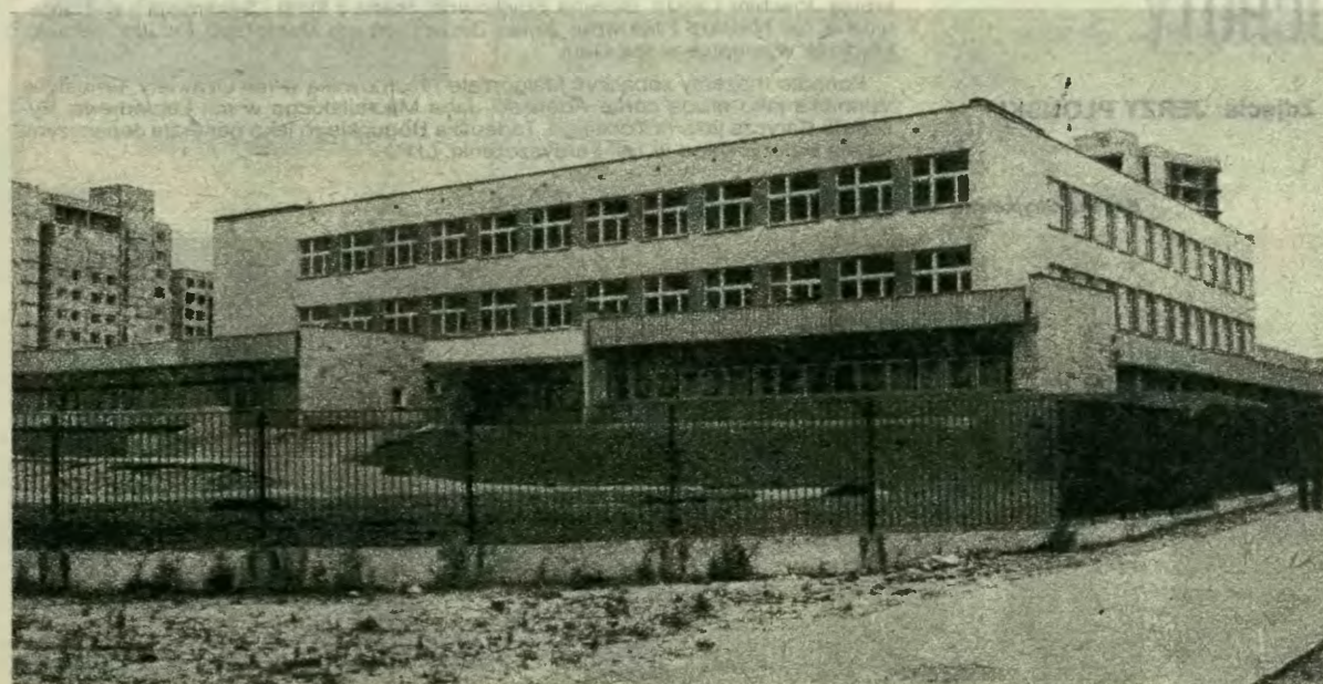
Szkoła podstawowa przy ul. Porajów 3 oddana do użytku młodym mieszkańcom osiedli Tarchomin I i Tarchomin II w lutym 1984 r.
