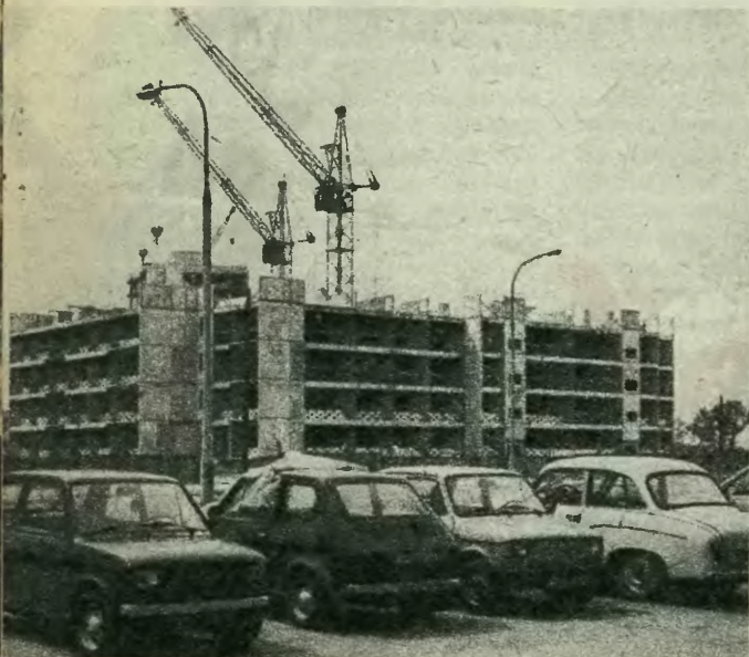
Na tarchomińskim placu budowy dźwigi stanowią sprzęt nieodczyny
