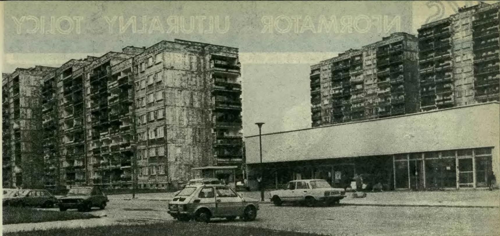
Bluki mieszkalne Tarchomina I oraz pawilon spożywczy widziane od ulicy frontowej
