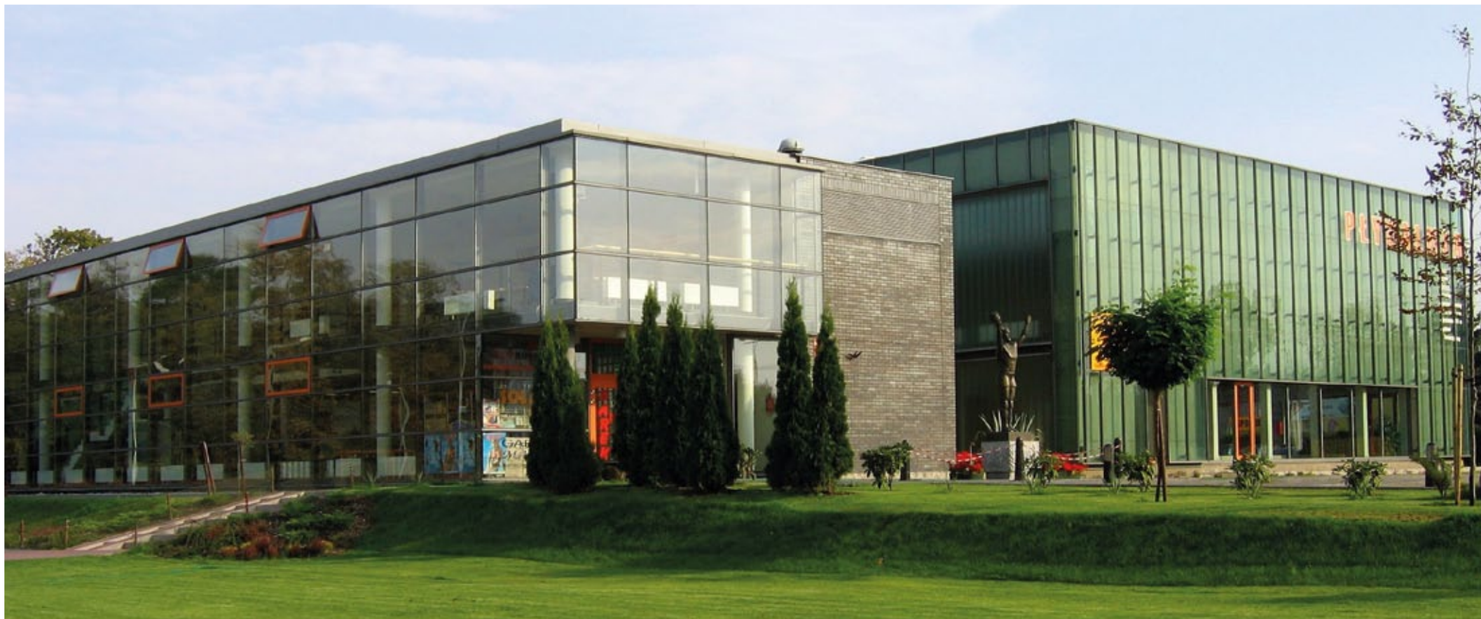
Pływalnia miejska w Ożarowie Mazowieckim
