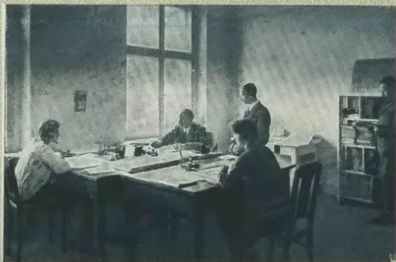
Stacja Selekcyjna Więclawice. — Pracownia asystentów.
