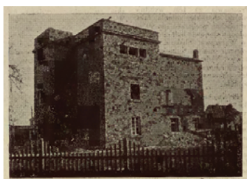
Budynek w trakcie generalnej przebudowy w 1930 roku
