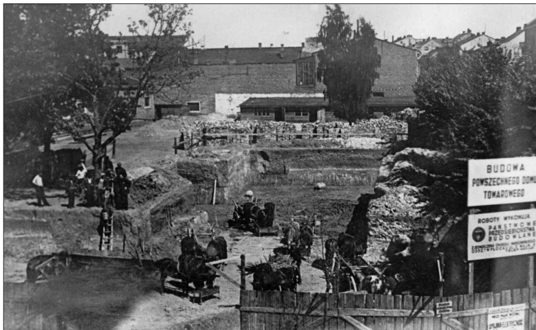
Rozpoczęcie budowy Powszechnego Domu Towarowego "Centrum", ul Tumska 11 Fotografia 1949 r., własność: J.Szymański
