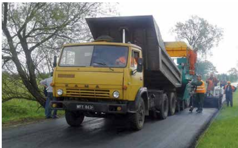
Modernizacja nawierzchni asfaltowej na drodze powiatowej Nr 2707W na odcinku od drogi wojewódzkiej do placu wiertni „Pęclin OU” w miejsc. Kąck
