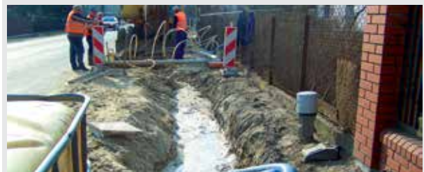
Budowa kanalizacji sanitarnej w miejscowości Grabianka
