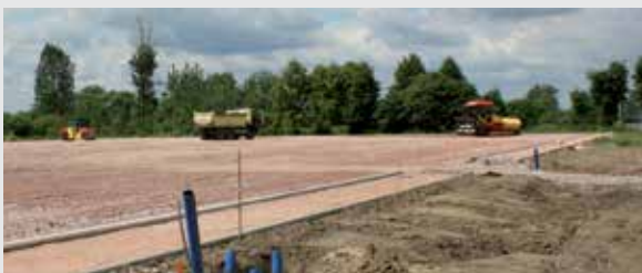
Przebudowa i modernizacja boiska treningowego na terenie stadionu LKS Mazur Karczew
