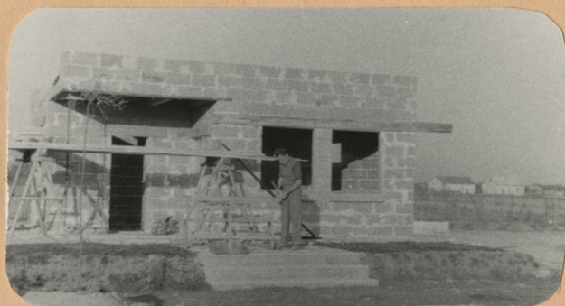
DOM W TRAKCIE BUDOWY
