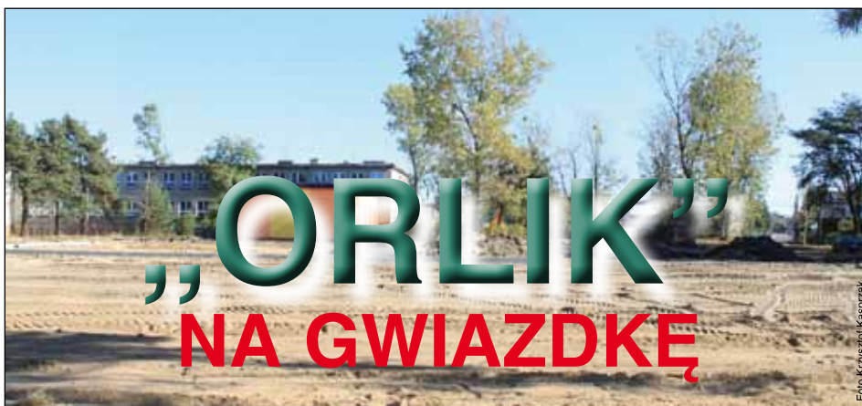
Gdy miesiąc temu robiłem to zdjęcie prace przy budowie Orlika dopiero się rozpoczynały
