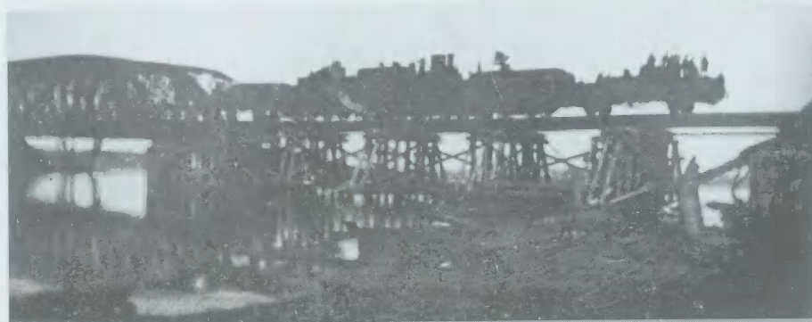
„Śmiały” przejeżdża przez prowizorycznie odbudowany most.
