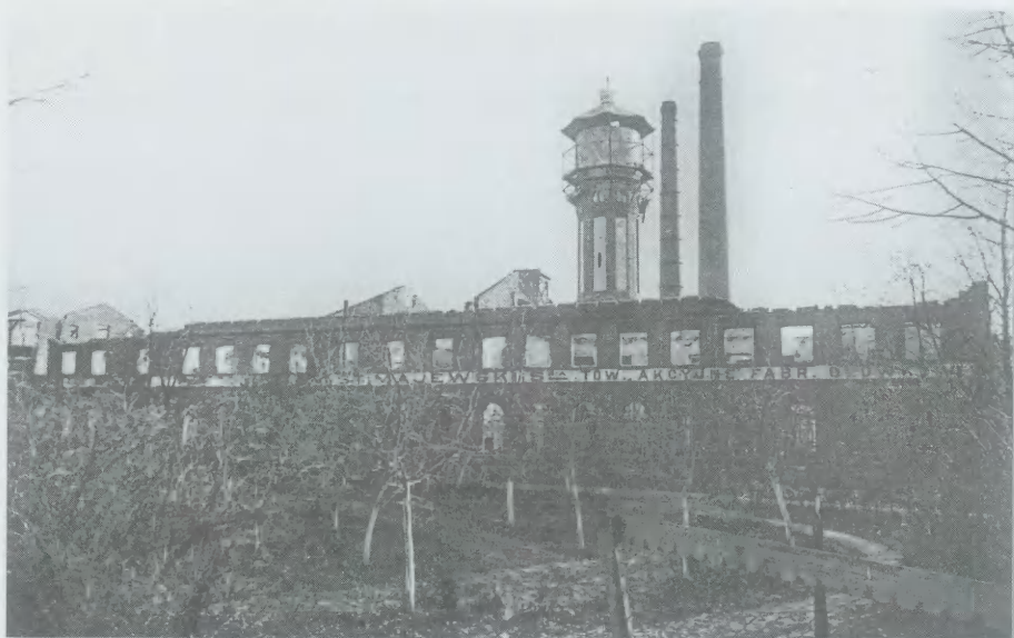
Zburzona w 1914 r. Fabryka Ołówków. Na pierwszym planie budynek główny.
