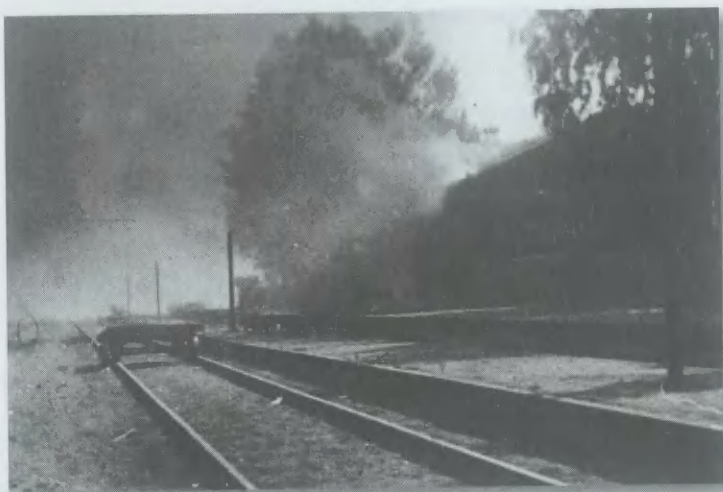
Plonąca stacja na szlaku kolejowym.
