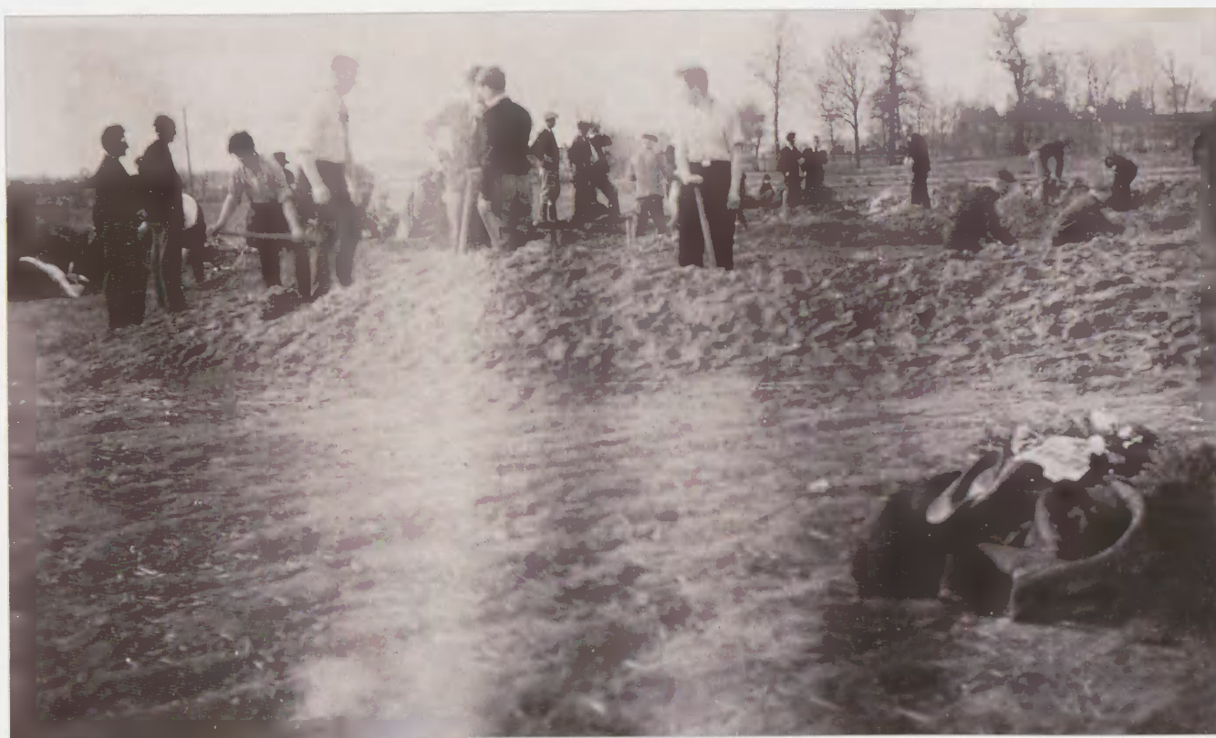
Zasypywanie zbiorowych mogił.
