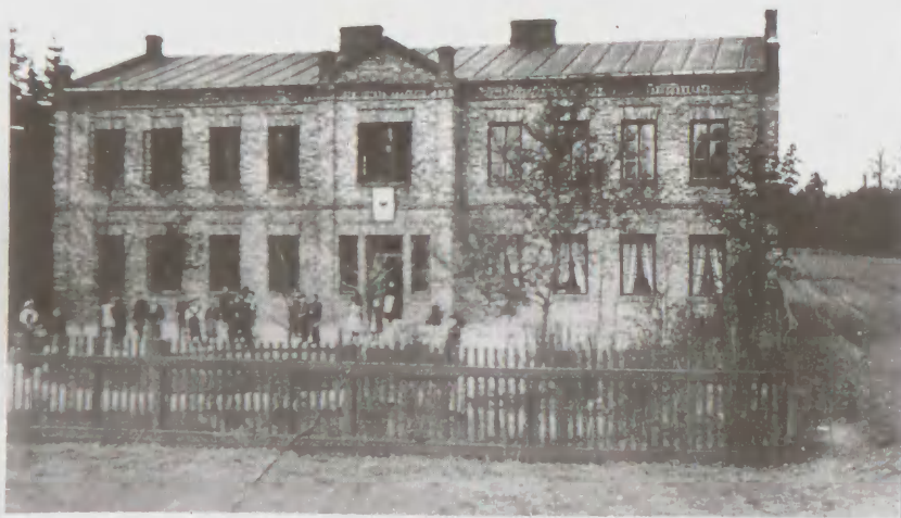
Budynek szkoły początkowej w Pruszkowie przy ul. Kościuszki; obecnie, po przebudowach, to budynek główny Liceum Ogólnokształcącego im. Kościuszki. [MSHM]
