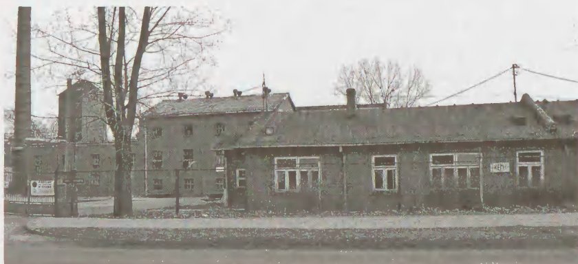
Budynki dawnej Kemi przy ul. Waryńskiego, obecnej Izolacji, najmniej zmieniły się od czasów przedwojennych (zdjęcie z 2008 r.).
