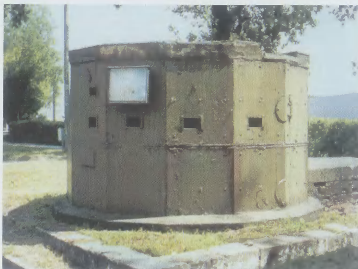
Bunkier przy dawnej bramie głównej, wymontowany przez Niemców z polskiego pociągu pancernego „Piłsudczyk”.
