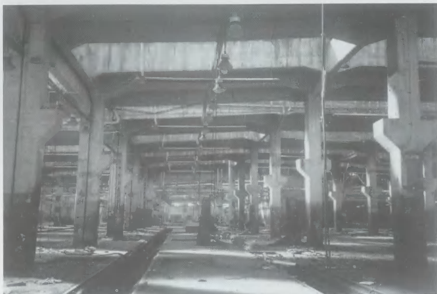
Widok wnętrza hali nr 5, późniejszego baraku nr 5.
