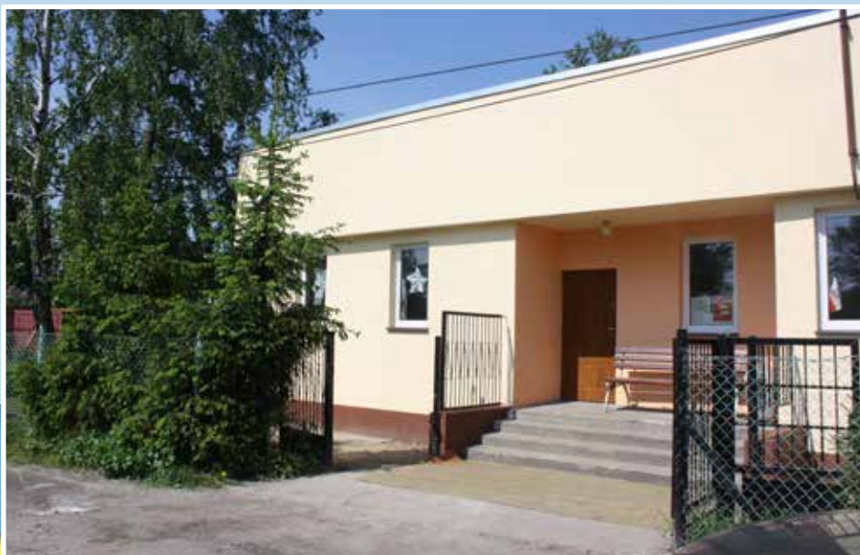
Tak wygląda teraz świetlica w Nadbrzeżu wyremontowana w dużej mierze za pieniądze unijne Foto arch. UM
