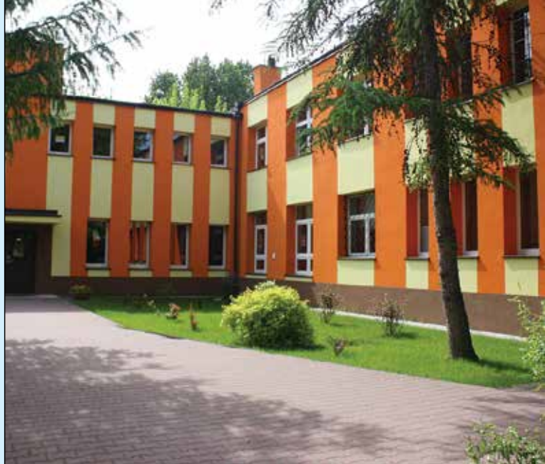
Szkoła Podstawowa w Otwocku Wielkim – jeden z dziesięciu obiektów poddanych termomodernizacji w formule ppp
