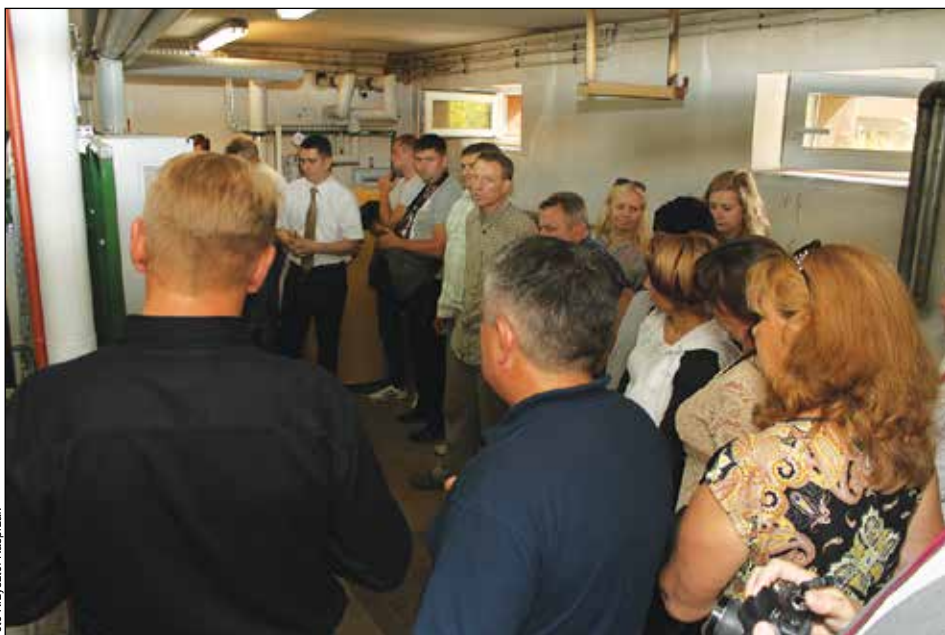
Goście zwiedzają nowoczesny węzeł ciepłowniczy Szkoły Podstawowej nr 2 w Karczewie
