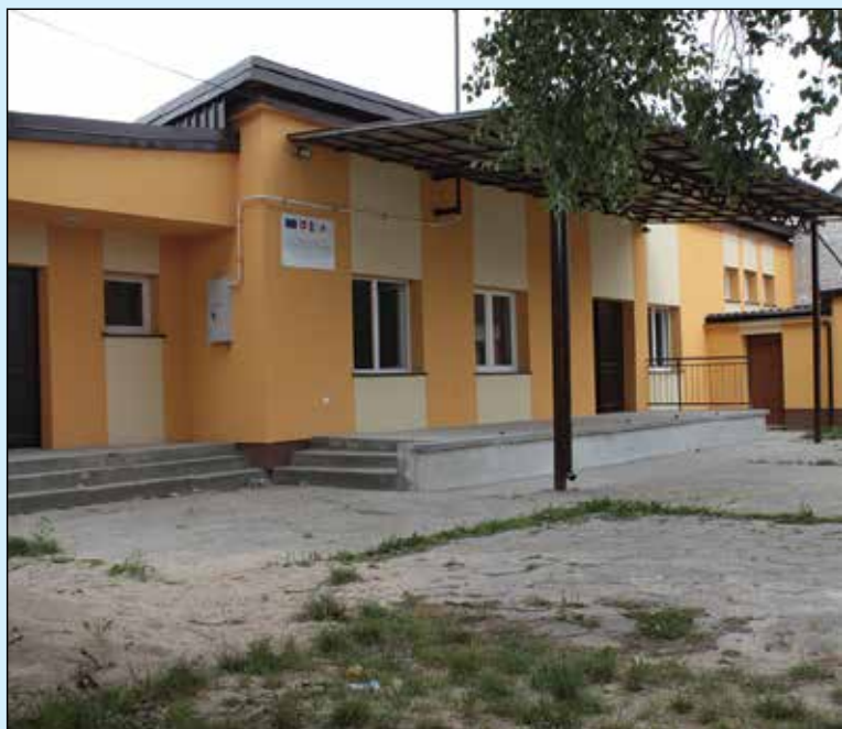
Wyremontowana świetlica w Glinkach
