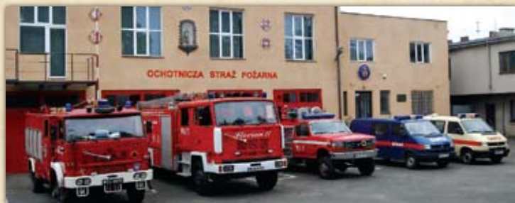
Aktualne zdjęcie remizy z samochodami przy ul. Żwirki i Wigury
