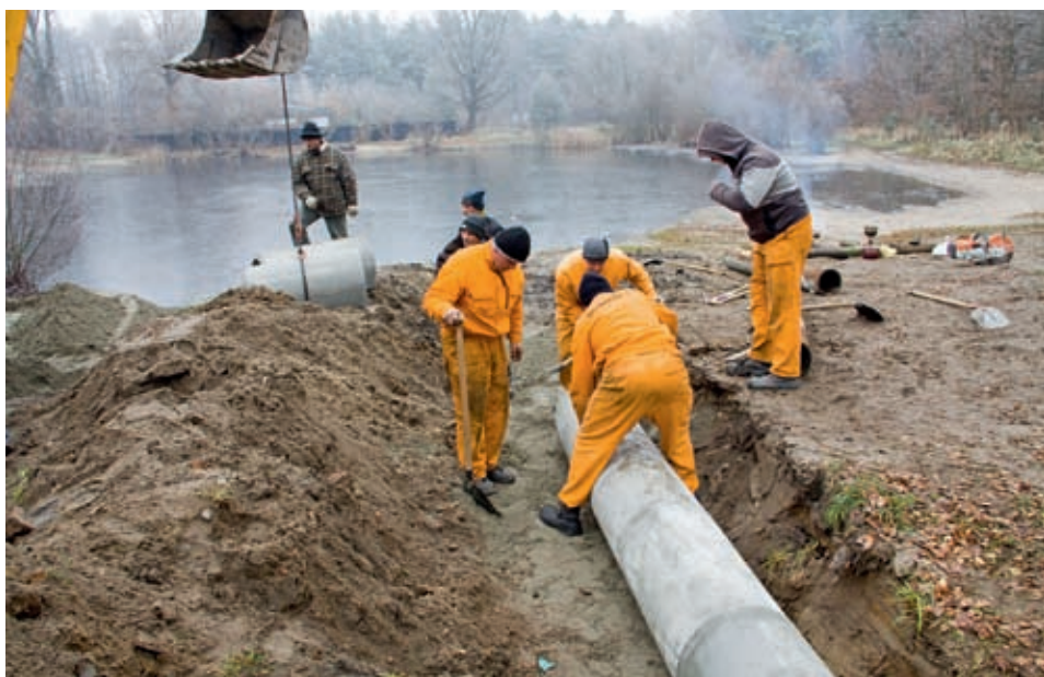
Rozpoczęły się pierwsze prace zmierzające do odwodnienia dzielnicy
