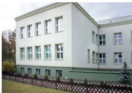
Zespół Szkół przy ul. Bajkowej po ociepleniu ścian
