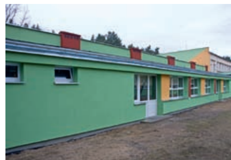
Nową elewację zyskała SP im. „Klonowego Liścia”, dziś już pięćdziesięcioletnia tysiąclatka
