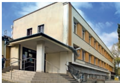
Dzięki ociepleniu ścian także Zespół Szkół przy ul. Koryneckiej zaoszczędzi do 30 proc. na ogrzewaniu budynku
