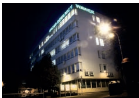
Urząd Dzielnicy przestał być anonimowym, zwłaszcza dla osób spoza Wawra, budynkiem. Zainstalowano na nim neon podświetlany energooszczędnymi żarówkami LED
