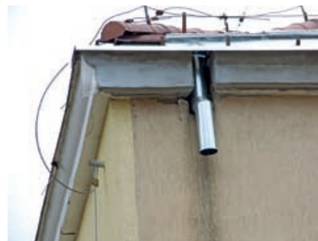
W jednych placówkach szkolnych izolowano fundamenty, w innych wykonywano niezbędne obróbki blacharskie, jak np. przy ul. Wilgi
