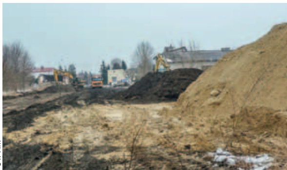
Początek prac przy ul. Panny Wodnej
