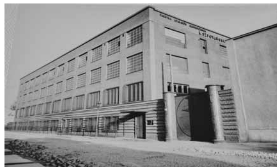
Jedna z nowoczesnych hal Fabryki Aparatów Elektrycznych zbudowana przez Szpotańskiego na Kamionku
