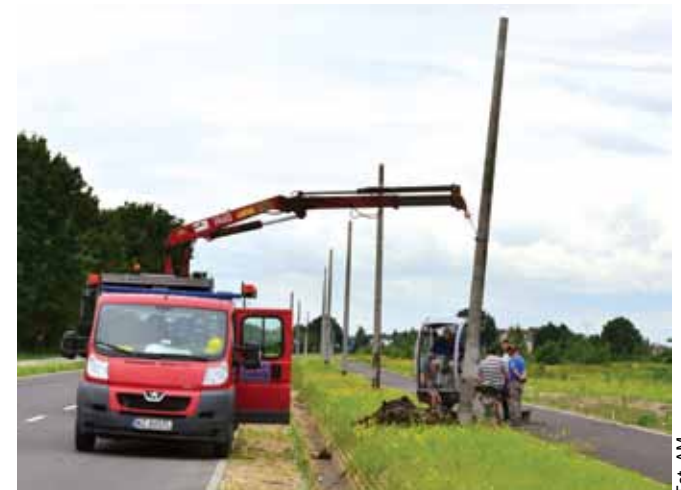
Wzdłuż nowego odcinka ul. Panny Wodnej wykonywane jest oświetlenie. Staną tam 62 słupy z energooszczędnymi lampami sodowymi
