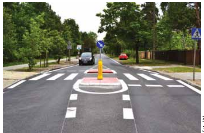
Ul. Izbička od ul. Olchy do ul. Przełęczy ma już nową asfaltową nawierzchnię wykonaną przez ZDM i chodnik od ul. Radłowej do ul. Izerskiej zbudowany przez dzielnicę (dalszy odcinek powstanie po wykonaniu kanalizacji)
