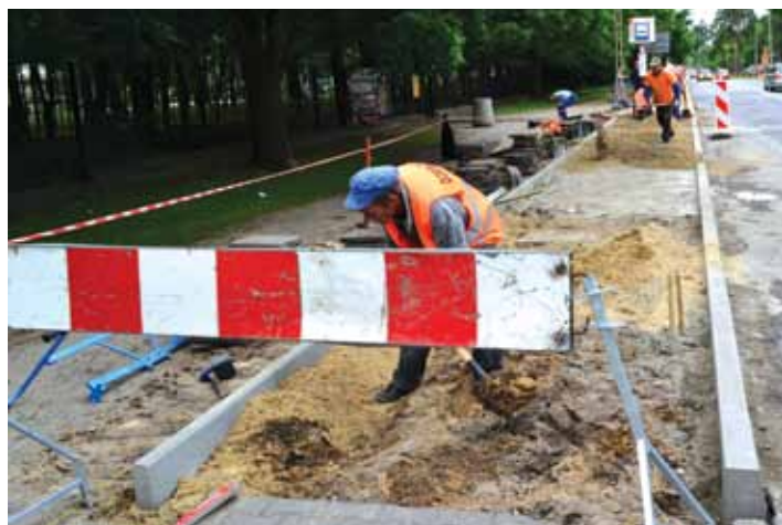
Trwa już budowa nowego chodnika wzdłuż ul. Kajki i Pożaryskiego
