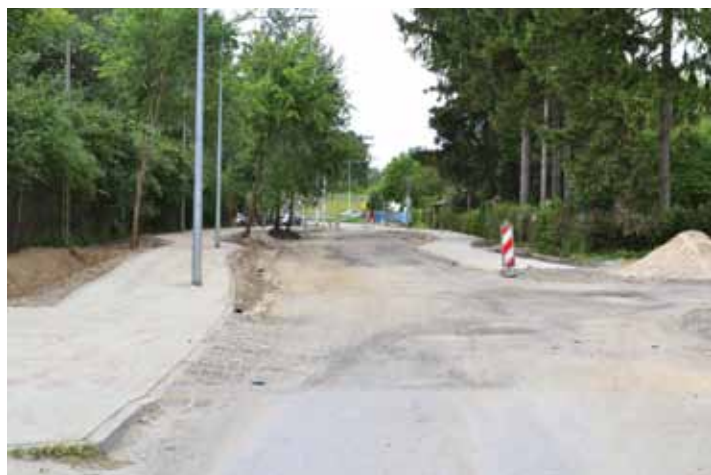
Przebudowywany jest fragment ul. Słalnicowej od Kuligowskiej do Heliotropów, z jednoczesnym jego poszerzeniem
