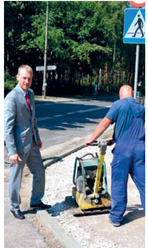
Kontrole realizacji inwestycji prowadzą inspektorzy nadzoru z Urzędu Dzielnicy, ale bardzo często jakość wykonanych prac sprawdza wiceburmistrz Adam Godusławski. Tu na budowie chodnika przy ul. Pożaryskiego w pobliżu skrzyżowania z ul. Niemodlińską
