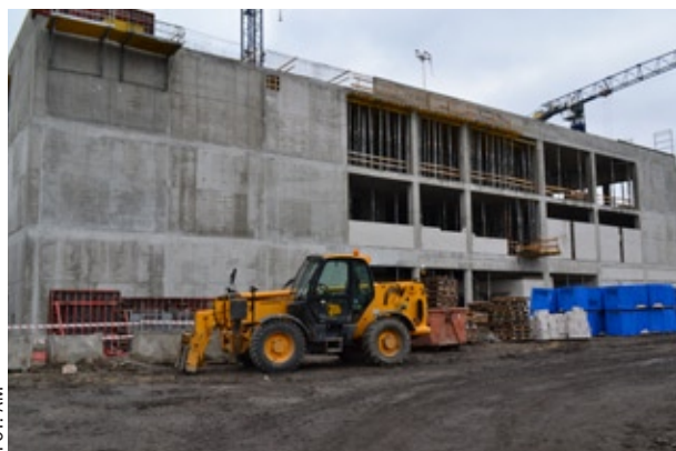
To nad tym dwupiętrowym budynkiem handlowo-usługowym zawisła wiecha.
