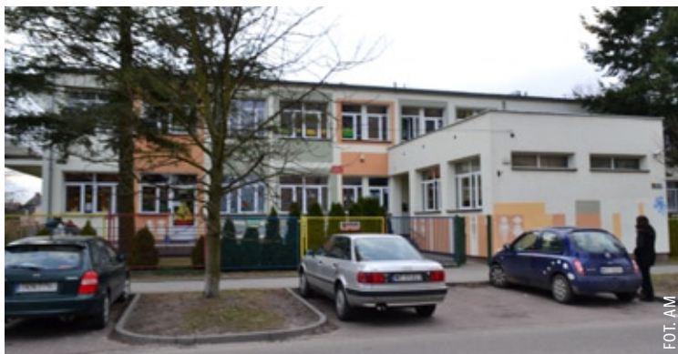
Jedne poważniejsze prace tej 42-letniej placówki polegały na wykonaniu termomodernizacji budynku
