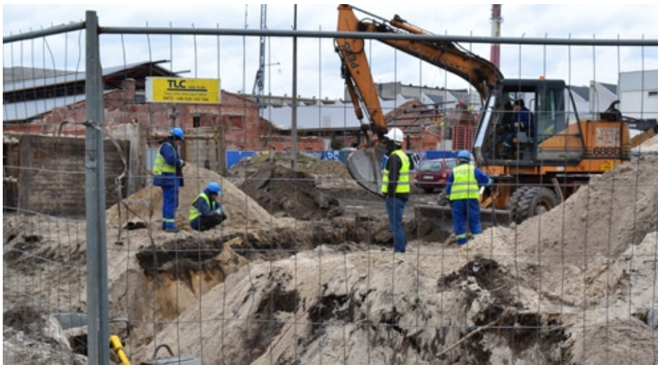
Roboty przygotowawcze przed tunelowymi na terenie ABB
