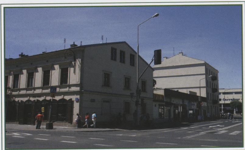
Odrestaurowane kamienice przy ul. Żąbkowskiej 13
