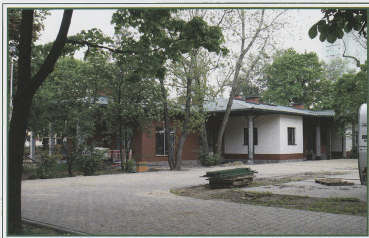
Ogród przy ul. Namysłowskiej w trakcie remontu
