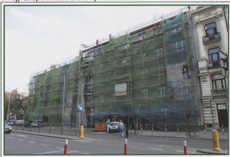
Remont elewacji budynków Białostocka 6 i 8
