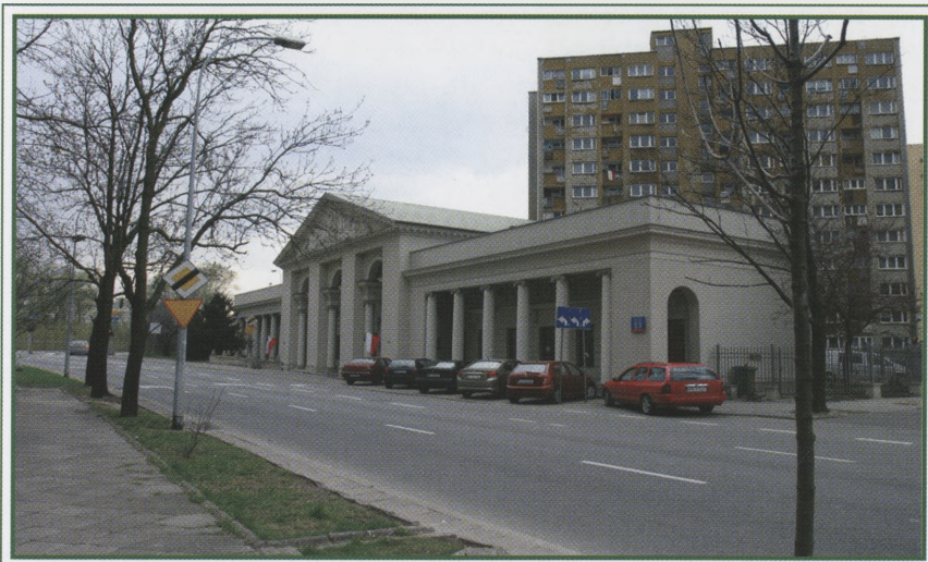
Budynek Urzędu Stanu Cywilnego (d. Komora Wodna)
