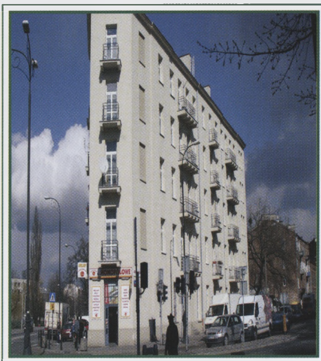
kamienica przy ul. Radzywińskiej 2 po remoncie elewacji
