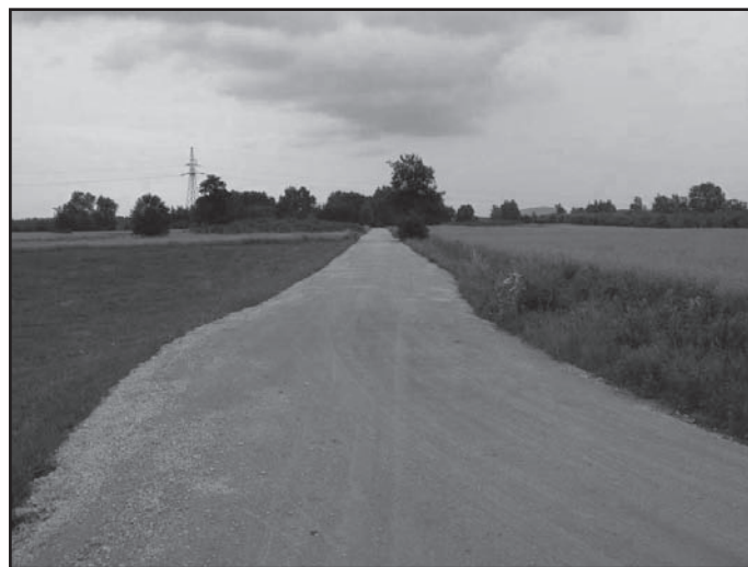
Droga w Kotorydzu po utwardzeniu
