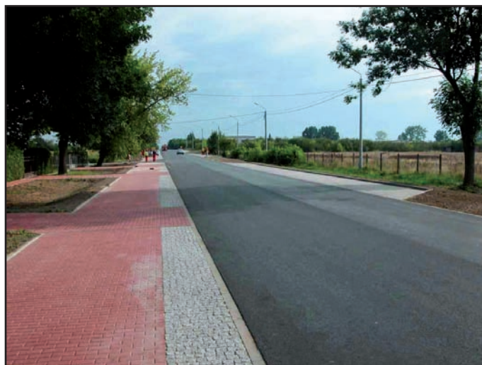
Zmodernizowana ulica Warszawska w Tarczynie
