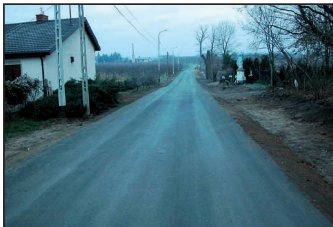
Zmodernizowana ulica Ogrodowa w Kopanej
