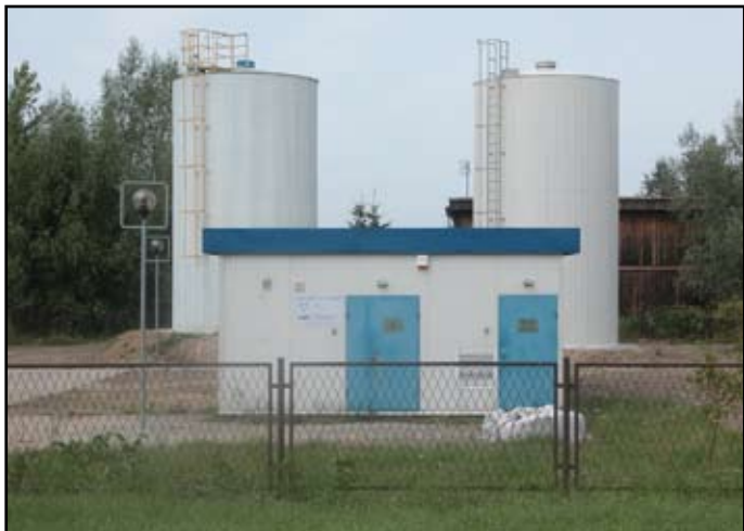
Rozbudowana Stacja Uzdatniania Wody w Pawłowicach
