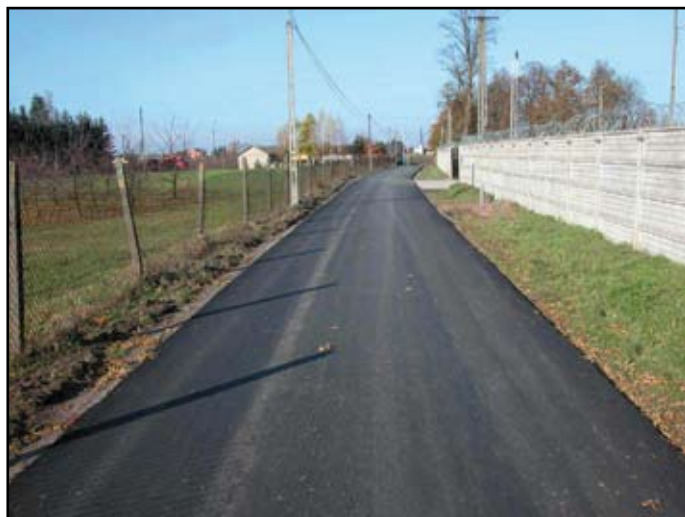
Nakładka asfaltowa na ul. Ogrodowej w Kopanej
