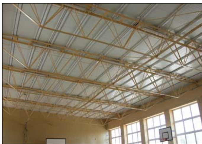
Nowoczesna konstrukcja dachu sali gimnastycznej w Tarczynie
