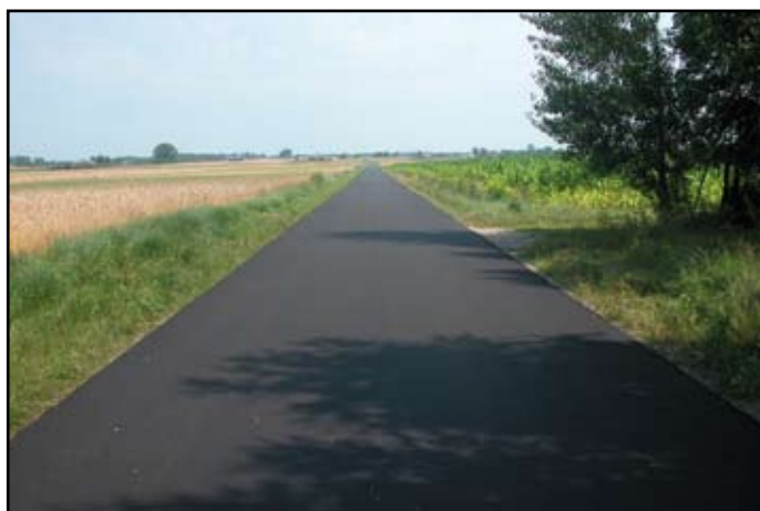
Zmodernizowana ul. Północna, Przypki
