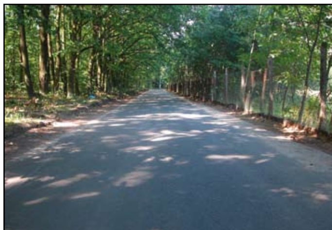
Zmodernizowana ul. Leśna w Korzeniówce
