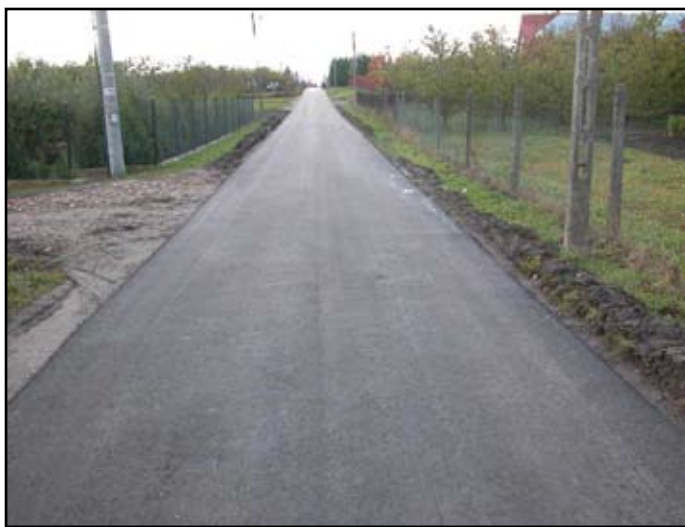
Zmodernizowana ul. Ogrodowa w Kopanej
