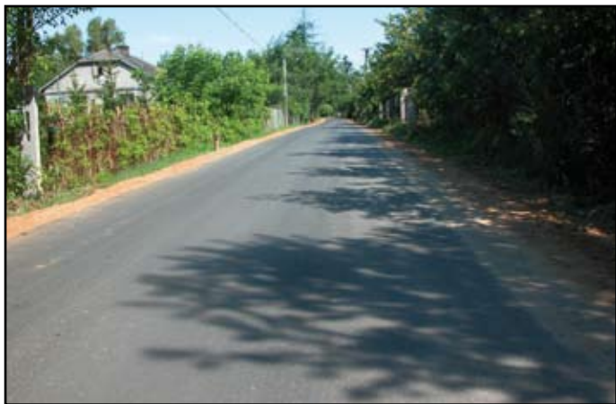
Ulica Topolowa w Korzeniówce po remoncie
