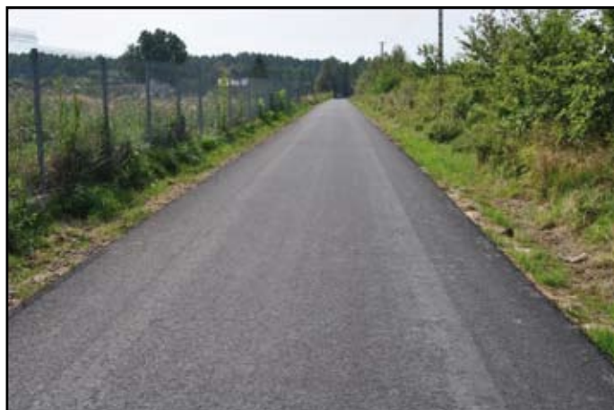
Ul. Wiśniowa w Pawłowicach po położeniu asfaltu
