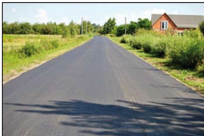
Zmodernizowana ul. Centralna w miejscowości Wylezin
