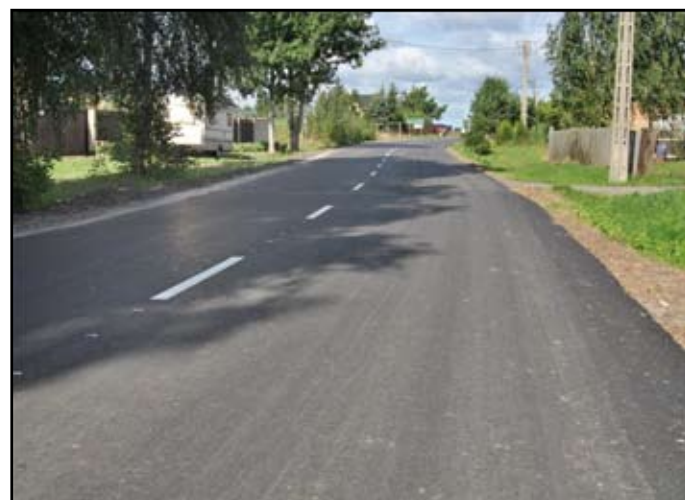
Ul. Piękna w Wola Przypkowskiej po przebudowie
