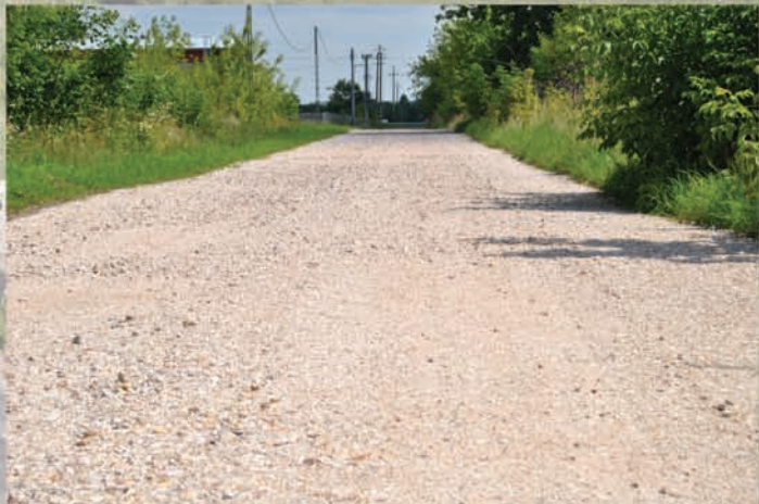
NOWA NAWIERZCHNIA NA UL. ŻYTNIEJ W TARCZYNIĘ
