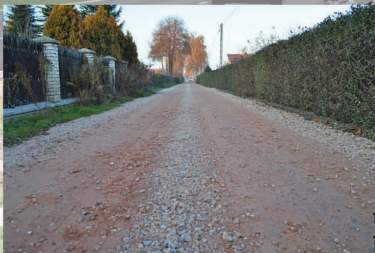
WZMOCNIONA I WYRÓWNANA NAWIERZCHNIA UL. GRANICZNEJ W RACIBORACH
