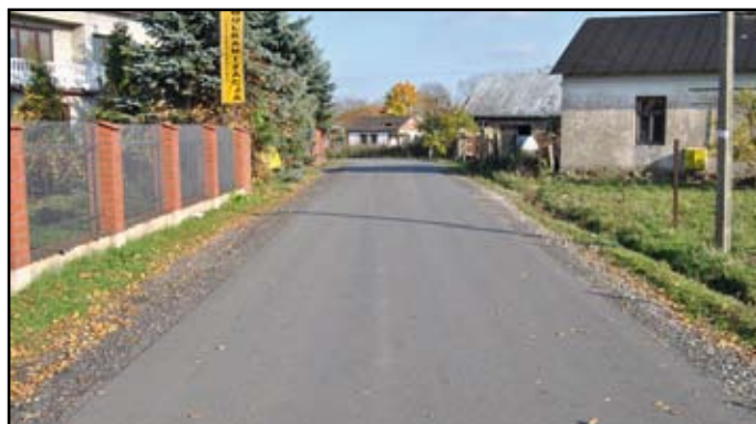
Zmodernizowana ul. Spokojna w Grzędach
