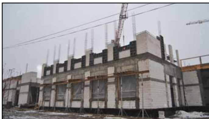
Nowy Dom Kultury w trakcie budowy
