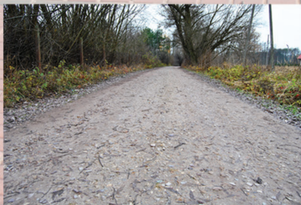
Ul. Pałacowa w Pracach Dużych po położeniu kruszywa
