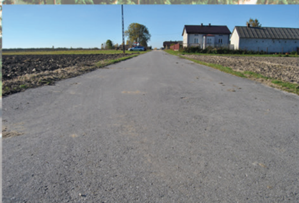
Na ul. Krótkiej w Woli Przypkowskiej położona została nakładka asfaltowa
