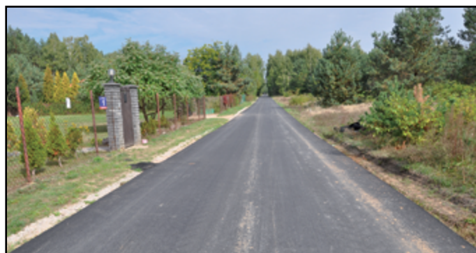
Ul. Wesola w m. Prace Duże
