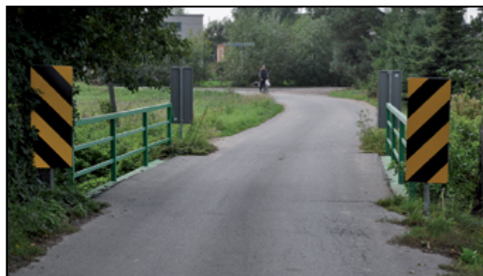
Most na ul. Jesionowej w m. Komorniki
