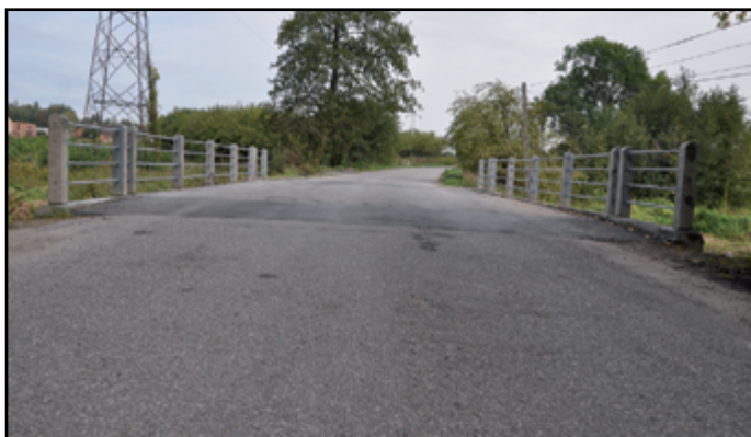
Most na ul. Leśnej w m. Komorniki
