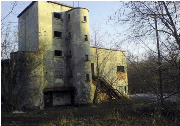
Fort Bema - budynki do wyburzenia
