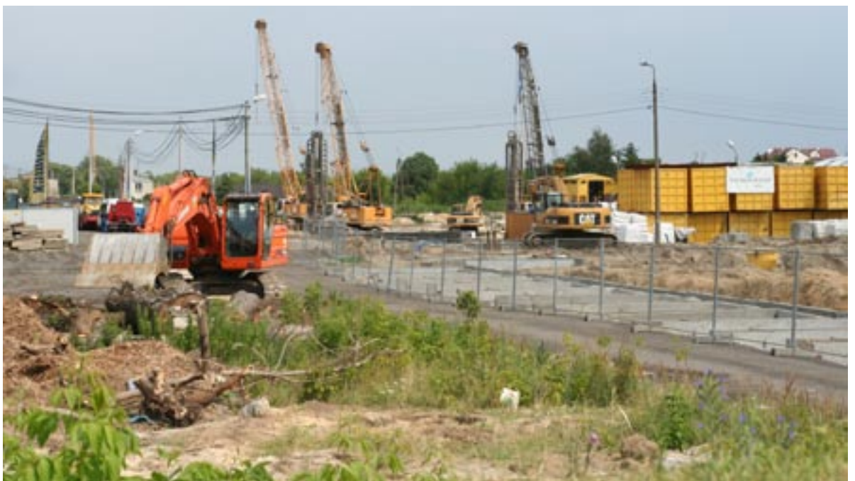
Widok z Powstańców Śląskich – nad trasą S-8 pracuje się nawet w weekendy
