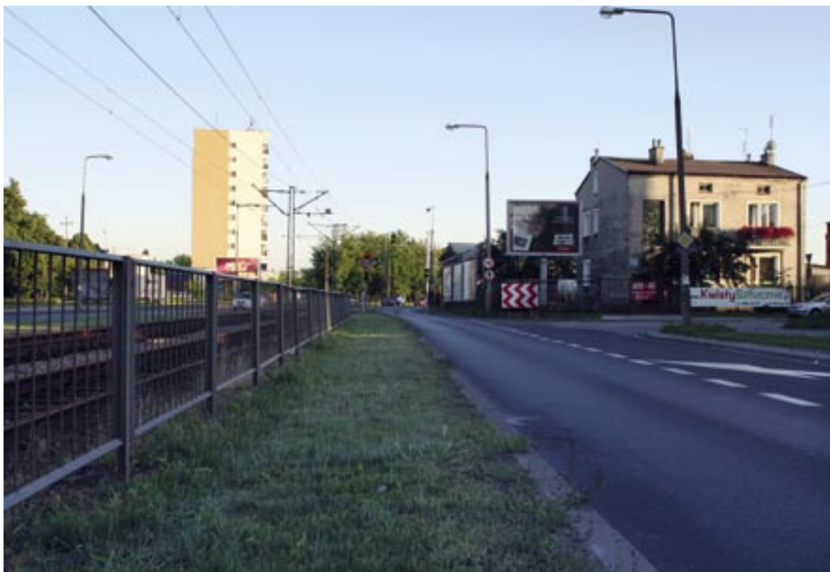
Po poszerzeniu ulicy jezdnia będzie przebiegać prawie pod domem
