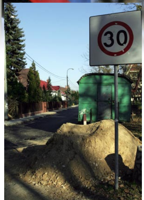
Remont Dostępnej utrudnia dojazd do posesji okolicznym mieszkańcom
