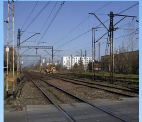
Przejazd kolejowy przy Strakowej – również modernizowany
