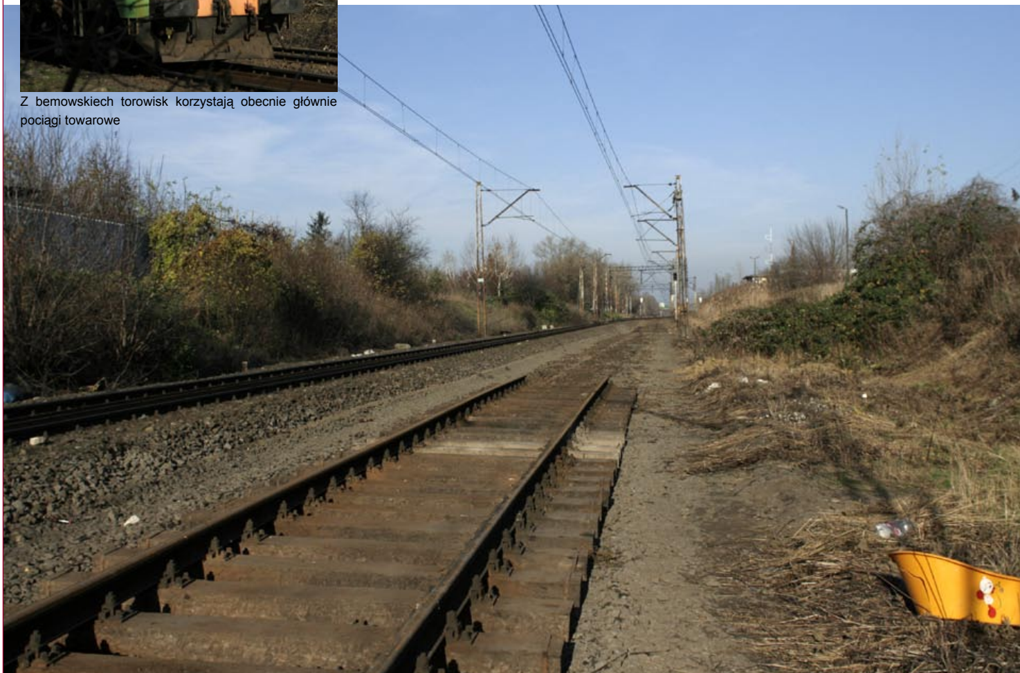
Pod koniec października rozpoczęto remont torowiska
