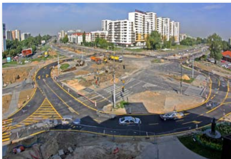
Prace przy budowie torów tramwajowych idą pełną parą
