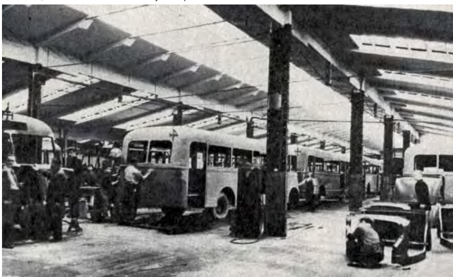
Blaszanka, montaż karoserii autobusowych na podwoziach Chevroleta w l. 1937–1939 ↓
