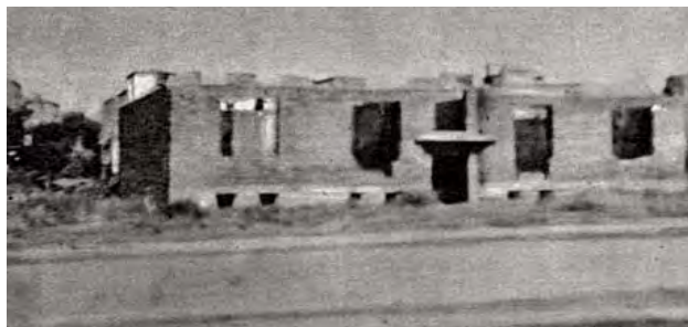
Miejsce zbiórki – nieukończony dom przy ul. Kasprowicza 46 ↓
