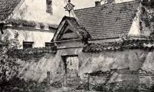
Murek między domkami z niezachowaną furtką z 1770 r. Stan przed 1931 r. Zbiory R. Marcinkowskiego ↑
