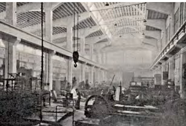
Wnętrze Bloku Warsztatów Remontowych, 1956 r. Fot. Z. Siemaszko ↑
