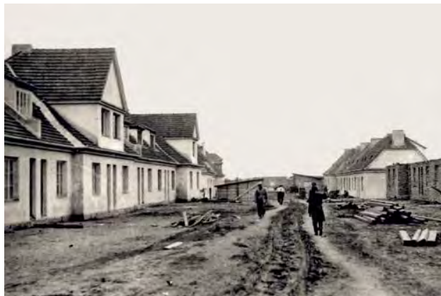
Budowa domów osiedla Zdobycy Robotnicza przy ul. Chełmżyńskiej (obecnej Płatniczej), 1927 r. Zbiory NAC ↑
