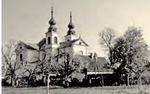
Widok na erem i kościół od strony prezbiterium.
