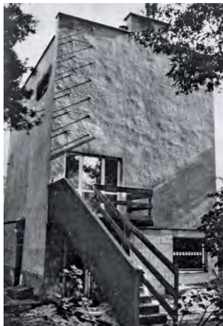
Elewacja ogrodowa domu Nowickich w l. 70. XX w. ↓
