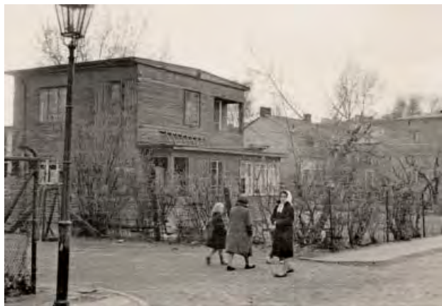
Domek przy ul. Lesznowskiej 2, róg Grębałowskiej, rozebrany w latach 90. XX w. Fot. A. Leszczyński, ok. 1958 r. ↑
