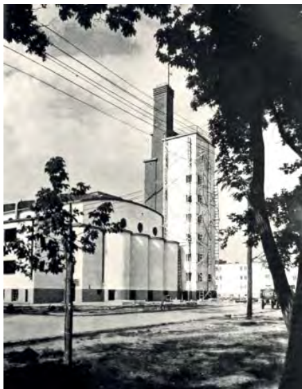
Wieża, kottownia i pływalnia CIWF, 1930 r. ↓
