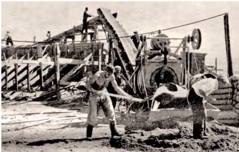
Pierwsze wykopy pod Hutę Warszawa, 1952 r. ↑
