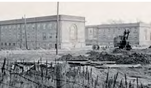
PIHM – wczesna faza budowy, grudzień 1956 r. Fot. A. Leszczyński ↑
