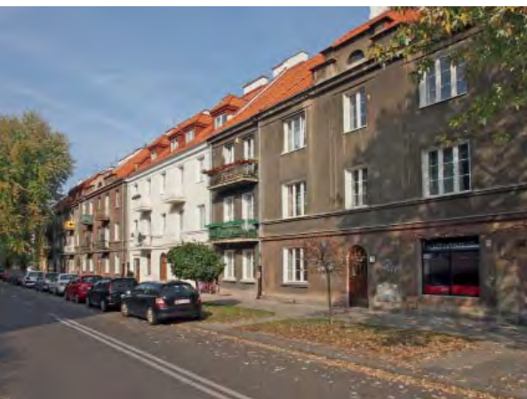
Kamienice przy ul. Schroegera ↑
