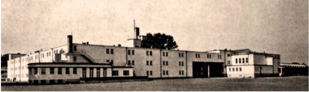
Gmach główny od strony pld.-wsch. w 1930 r. ↑
