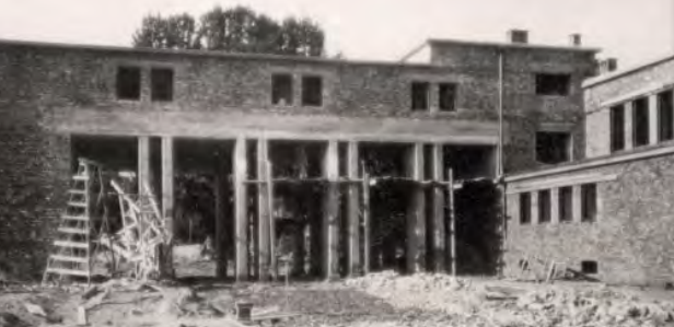
Budowa segmentu łącznika w gmachu głównym, 1929 r. ↑
