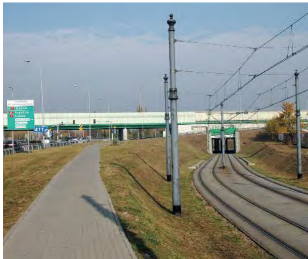
Trasa Mostu Północnego na osi ul. Marymonckiej ↑
