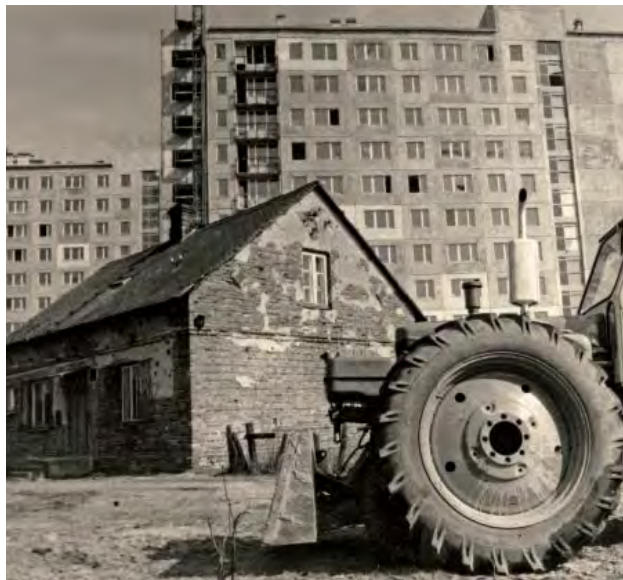
Budowa osiedla. Fot. J. Pieńkowski, 1976 r. ↑
