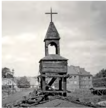
Spalona sygnaturka kościoła ↑
