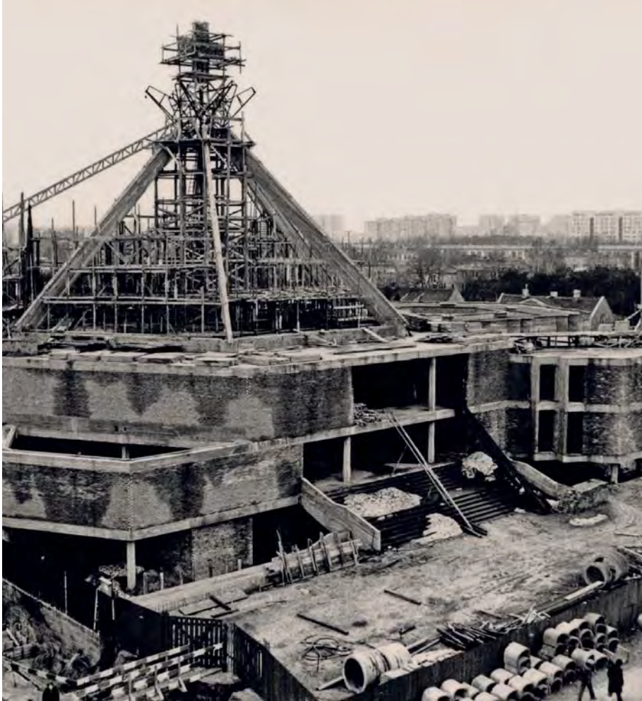
Kościół św. Zygmunta w budowie, 1981 r. ↑
