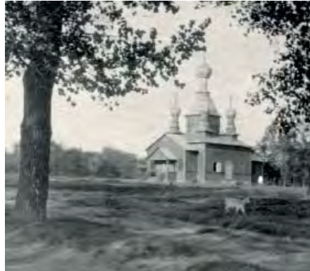
Cerkiew polowa przy ul. Marymonckiej, 1916 r. ↑
