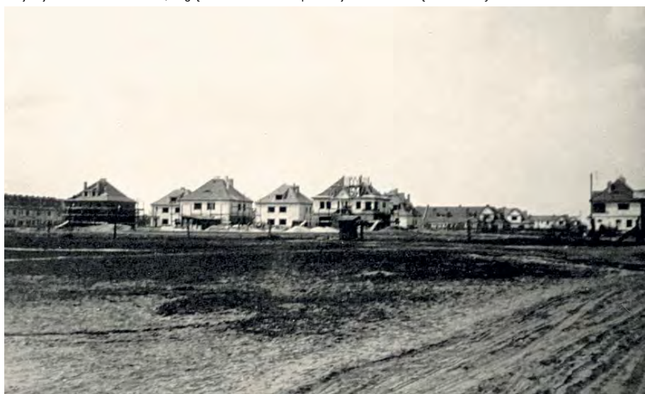
Aleja Zjednoczenia w 1928 r.; w głębi zabudowa ul. Lipińskiej. Fot. H. Poddębski. Zbiory IS PAN ↓
