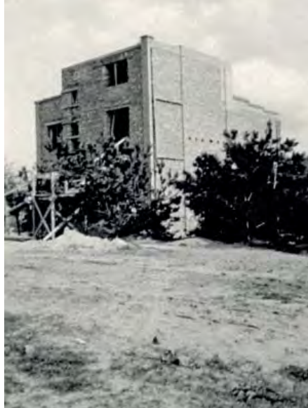
Budowa segmentu szeregowego przy ul. Fontany, ok. 1937 r. Zbiory Archiwum WKZ ↑
